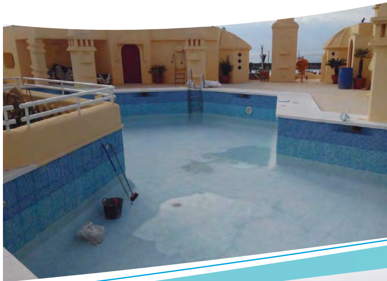
■ Colocación de nuevo gresite
