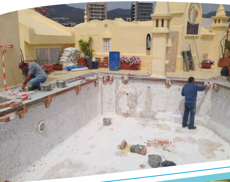
■ Reparación de vaso piscina en Cubierta Retirada de Gresite e impermeabilización
