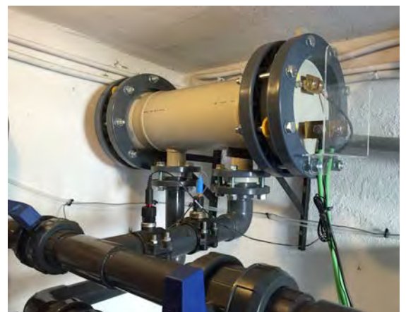
Detalle de célula industrial de Electrolisis
