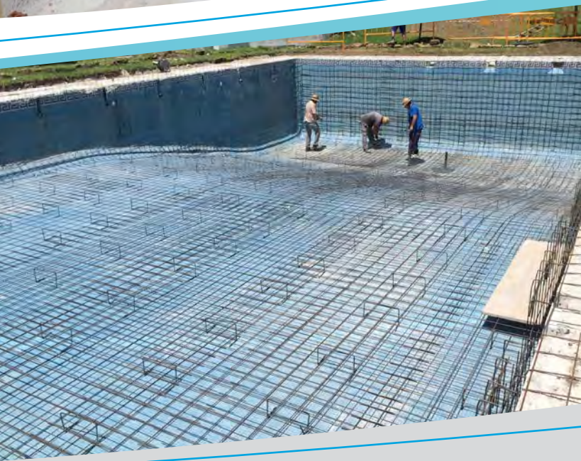
■ Colocación de nuevo mallazo en vaso piscina
