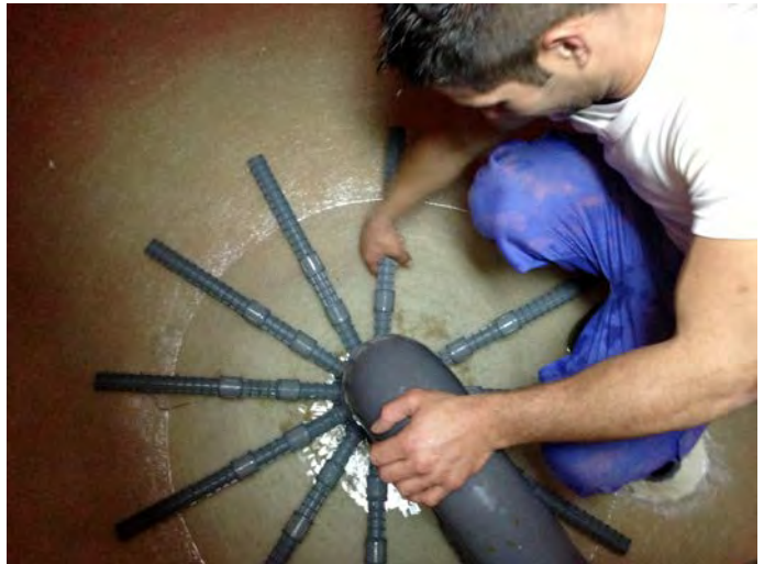
Sustitución de los colectores en un filtro
